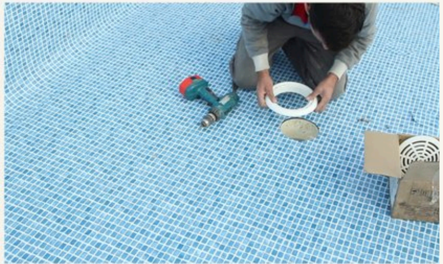
Gerçek Sermed montaj fotoğrafı: dip emişin son liner / flanş bağlantısı. Bu fotoğraf sonraki aşamanın bağlantısını açıklamak içindir.
